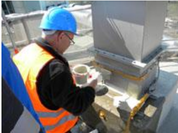
Triflex Kraftwerk Hamm03.jpg
