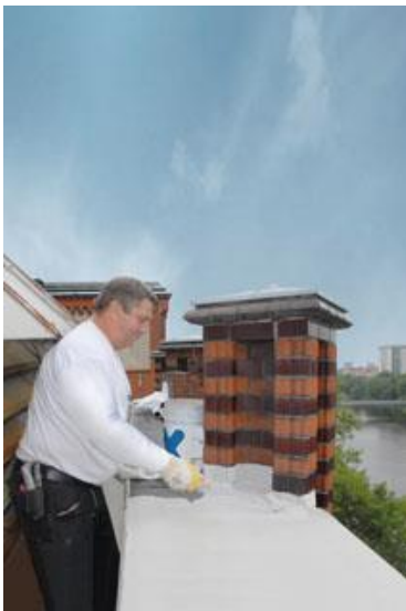
Triflex Maschinenhaus Vattenfall02.jpg
