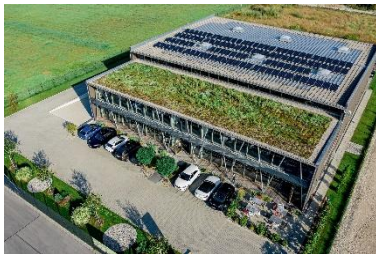
Zambelli_Vorbericht Dach+Holz 2024_08.jpg
