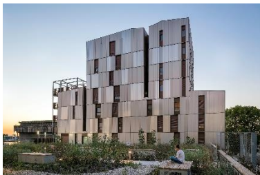
Zambelli_Vorbericht Dach+Holz 2024_06.jpg
