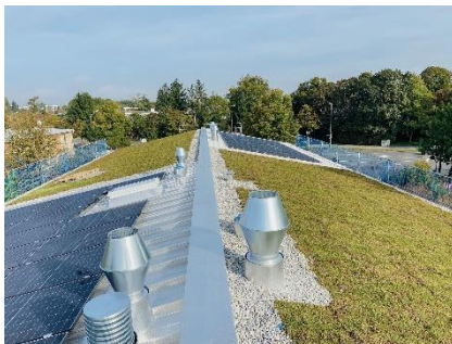
Zambelli_Vorbericht Dach+Holz 2024_09.jpg
