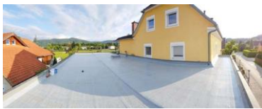
Triflex_Flachdach Krumpendorf 06.jpg
