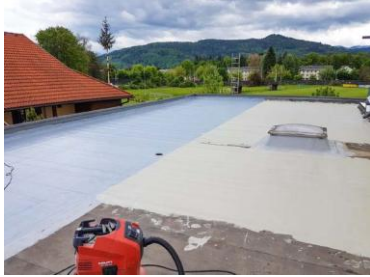
Triflex_Flachdach Krumpendorf 05.jpg
