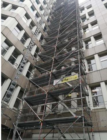
Sifatec\_FGZ Düsseldorf04.jpg Für einen optimalen Zugang zu dem hochgelegenen Arbeitsplatz ergänzte Objektplaner Hubert Wegener sein Gerüstbau-Konzept um einen Treppenturm und einen Bauaufzug der Firma Sifatec.
