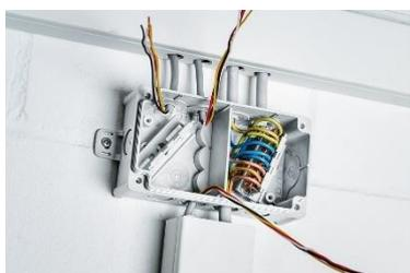
Spelsberg\_Abox 025-2\_03.jpg Auch das Zubehörangebot hat Spelsberg erweitert: Die Trennwand ermöglicht es, beispielsweise zwei verschiedene Installationsbereiche voneinander abzugrenzen. Darüber hinaus gewährleisten die Klemmenhalter eine einfache Befestigung der Installations- und Reihenklemmen sowie eine flexible Positionierung im Abzweigkasten.
