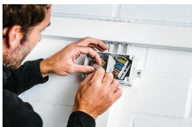
Spelsberg\_Abox 025-2\_02.jpg Mit durchgängigen Mittenmarkierungen und weichen, selbstdichtenden Einführungsmembranen gestalten sich die Installation des Abzweigkastens sowie Wartungsarbeiten für Elektroinstallateure besonders effizient und angenehm.
