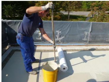
Triflex_Parkhaussanierung- mit- Flüssigkunststoff_06.jpg
