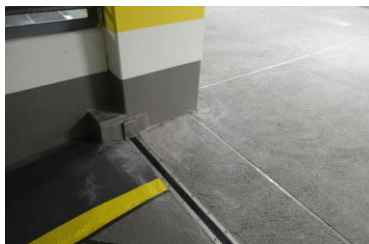
Triflex_Parkhaussanierung- mit- Flüssigkunststoff_07.jpg
