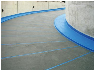
Triflex_ Beheizte Abdichtung_03.jpg
