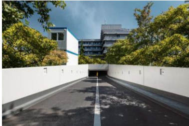
Triflex_ Beheizte Abdichtung_01.jpg
