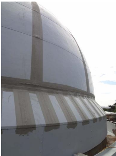
Triflex Abdichtung von Metalldächern05.jpg
