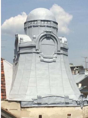
Triflex Abdichtung von Metalldächern01.jpg
