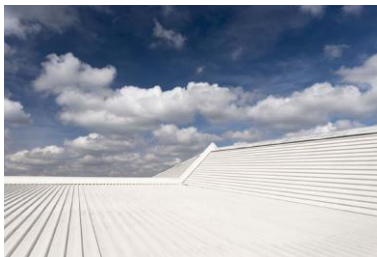
Triflex Abdichtung von Metalldächern03.jpg
