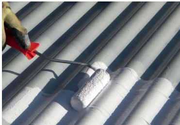
Triflex Abdichtung von Metalldächern02.jpg
