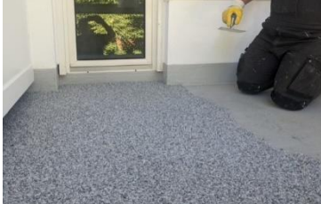
Triflex_Balkonsanierung Münster Stone Design_04.jpg
