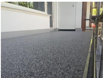
Triflex_Balkonsanierung Münster Stone Design_05.jpg
