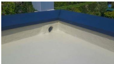
Triflex Nutzungsänderung Flachdach 07.jpg
