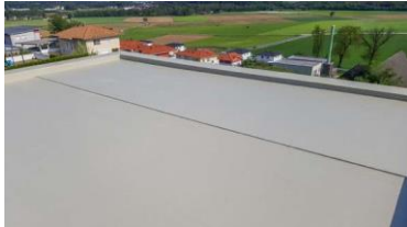
Triflex Nutzungsänderung Flachdach 06.jpg
