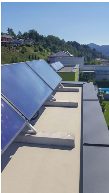
Triflex Nutzungsänderung Flachdach 08.jpg
