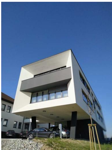
Triflex Parapet Bürogebäude Aspöck06.jpg
