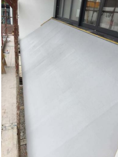
Triflex Parapet Bürogebäude Aspöck05.jpg
