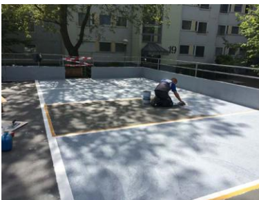
Triflex Parkdeck Salzgitter07.jpg
