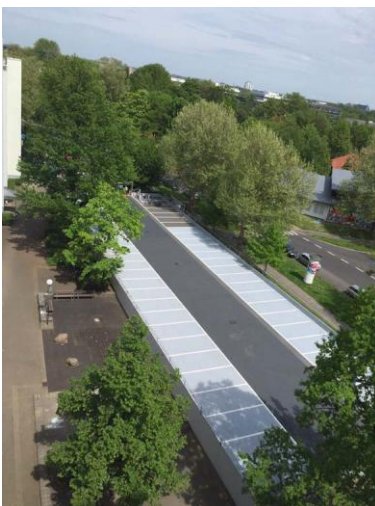
Triflex Parkdeck Salzgitter08.jpg
