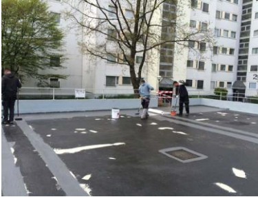
Triflex Parkdeck Salzgitter05.jpg
