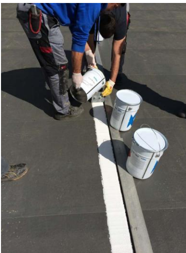
Triflex Parkdeck Salzgitter06.jpg
