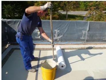
Triflex_Parkhaussanierung- mit- Flüssigkunststoff_06.jpg
