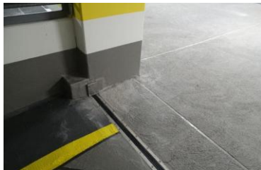
Triflex_Parkhaussanierung- mit- Flüssigkunststoff_07.jpg
