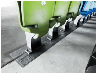
Triflex Sanierung im Stadionbau05.jpg
