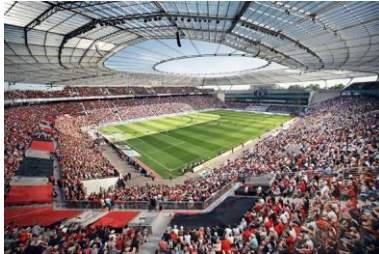
Triflex Sanierung im Stadionbau01.jpg
