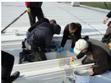
Triflex Sanierung im Stadionbau07.jpg
