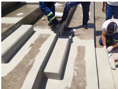
Triflex Sanierung im Stadionbau03.jpg
