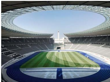
Triflex Sanierung im Stadionbau02.jpg
