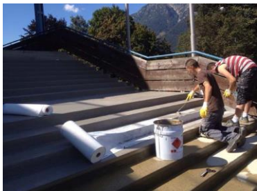
Triflex Sanierung im Stadionbau04.jpg
