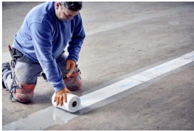
Triflex Tiefgarage Velbert05.jpg
