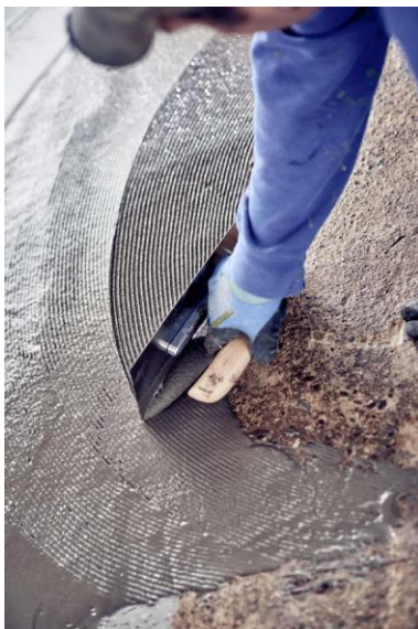
Triflex Tiefgarage Velbert07.jpg
