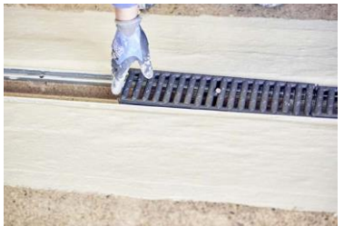
Triflex Tiefgarage Velbert06.jpg
