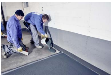
Triflex Tiefgarage Velbert08.jpg
