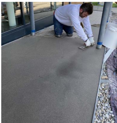
Triflex_Treppe Raika Schwand_04.jpg
