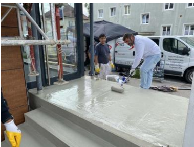
Triflex_Treppe Raika Schwand_06.jpg
