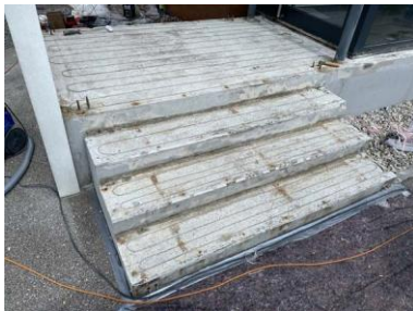
Triflex_Treppe Raika Schwand_03.jpg
