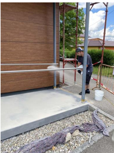
Triflex_Treppe Raika Schwand_07.jpg
