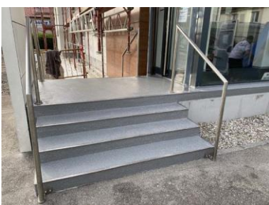
Triflex_Treppe Raika Schwand_08.jpg
