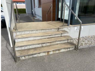
Triflex_Treppe Raika Schwand_01.jpg
