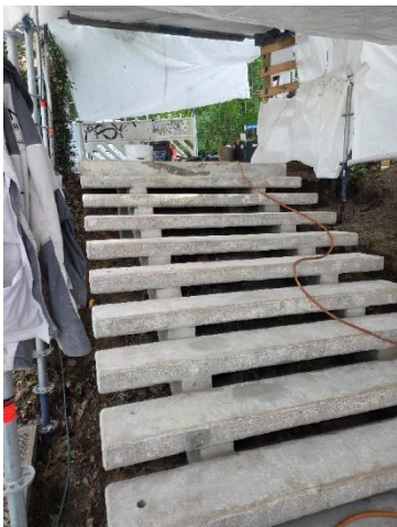
Triflex_Treppenanlage Sierksdorf 02.jpg
