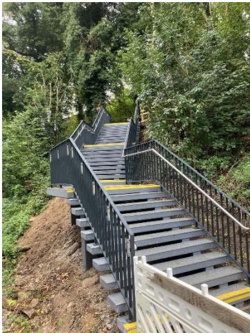
Triflex_Treppenanlage Hansapark 06.jpg
