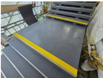
Triflex_Treppenanlage Hansapark 05.jpg
