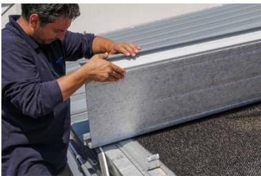
Zambelli\_Wohnungsbau\_06 Optimaler Lärmschutz: Das RIB-ROOF Akustikdach von Zambelli wird in standardmäßiger Verlegetechnik mit dem jeweiligen Clipsystem montiert. Dank seiner unterseitigen Akustikvliesbeschichtung reduziert das System den Regenschall um bis zu 6 Dezibel.
