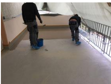
Triflex Terrassensanierung Maintal04.jpg
