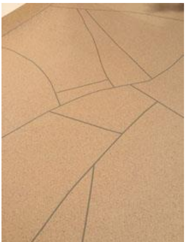
Triflex Terrassensanierung Maintal07.jpg
