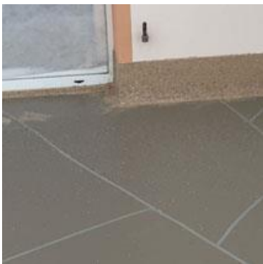
Triflex Terrassensanierung Maintal06.jpg
