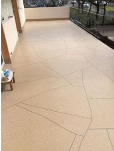
Triflex Terrassensanierung Maintal01.jpg
