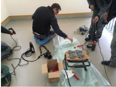
Triflex Terrassensanierung Maintal05.jpg
