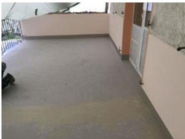
Triflex Terrassensanierung Maintal02.jpg
