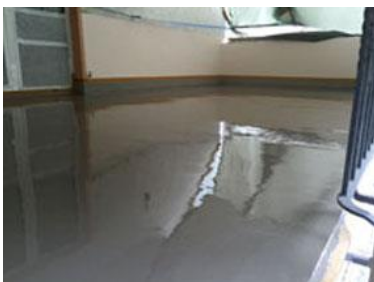
Triflex Terrassensanierung Maintal03.jpg
