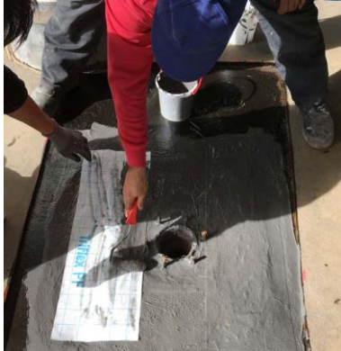
Triflex_Gully-Sanierung Parkhaus_04.jpg
