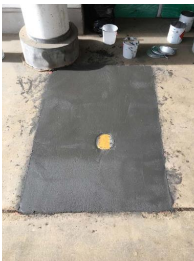
Triflex_Gully-Sanierung Parkhaus_06.jpg
