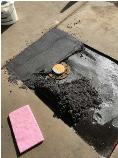
Triflex_Gully-Sanierung Parkhaus_05.jpg
