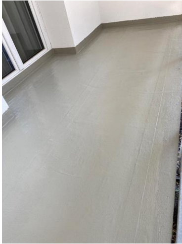
Triflex_Thermische- Balkonsanierung- Mistelbach_07.jpg
