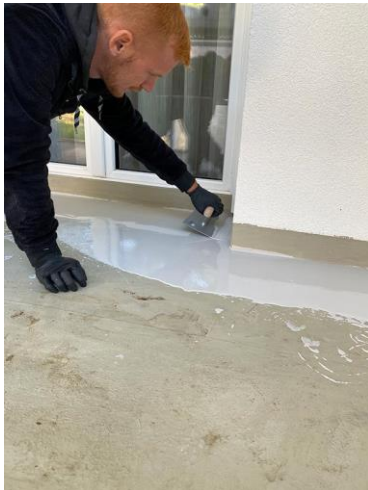
Triflex_Thermische- Balkonsanierung- Mistelbach_08.jpg
