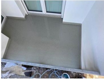
Triflex_Thermische- Balkonsanierung- Mistelbach_10.jpg
