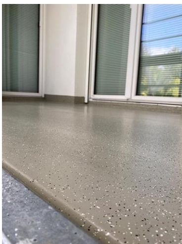
Triflex_Thermische- Balkonsanierung- Mistelbach_09.jpg
