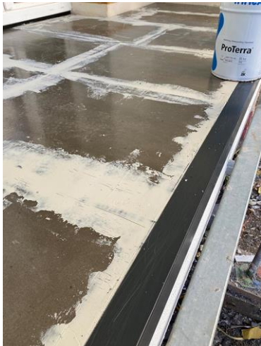
Triflex_Thermische- Balkonsanierung- Mistelbach_05.jpg
