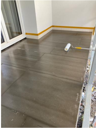
Triflex_Thermische- Balkonsanierung- Mistelbach_04.jpg
