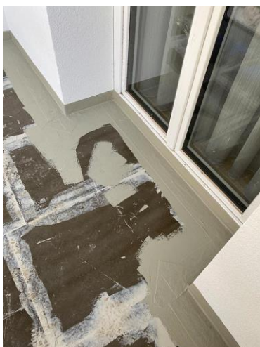
Triflex_Thermische- Balkonsanierung- Mistelbach_06.jpg
